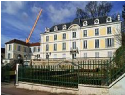
2 Salles à la Maison Vaillant
